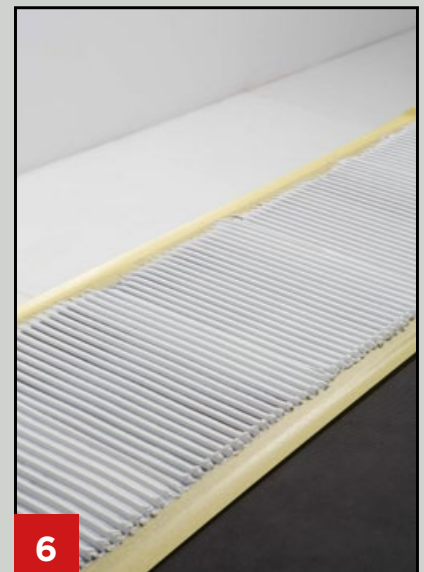
6 Stendere uniformemente LITOELASTIC EVO sulla superficie.
