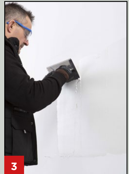
3 Stendere "a Zero" LITOELASTIC EVO con spatola liscia sul sottofondo senza lasciare residui di adesivo.
