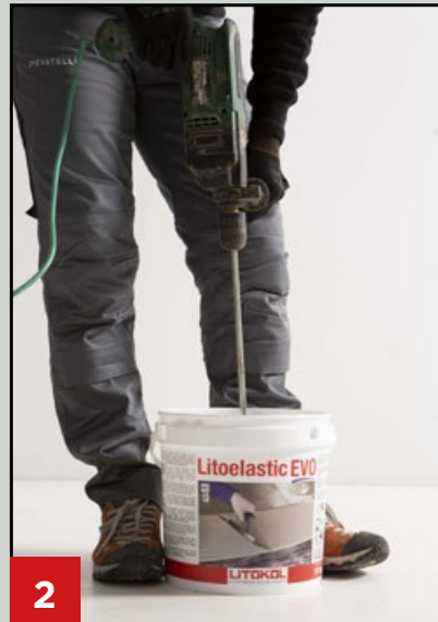
2 Miscelare LITOELASTIC EVO come indicato nella scheda prodotto.
