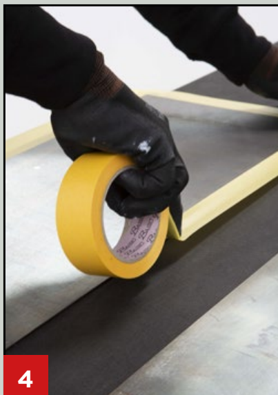
4 Usare del nastro adesivo in carta per proteggere il bordo (1/2 cm).
