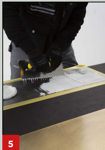
5 Stendere LITOELASTIC EVO con spatola da 3,5x3,5 mm sul retro della lastra nel verso del lato corto.
